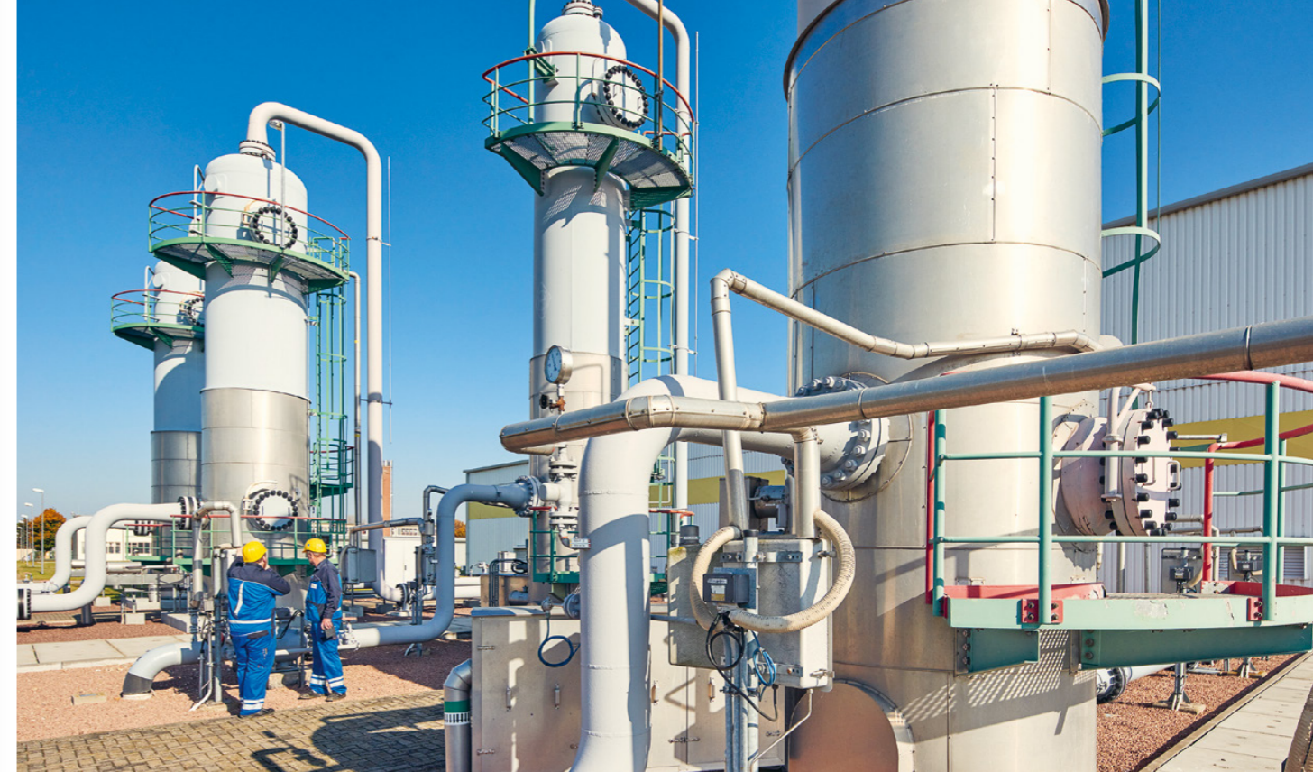
Kavernenspeicher Bad Lauchstädt: Vorbereitungen für die Speicherung von grünem Wasserstoff.
