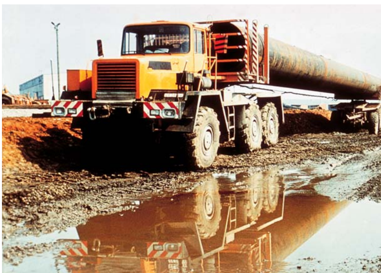
Schwere Zugmaschine der Firma FAUN aus dem bayrischen Lauf an der Pegnitz im Einsatz beim Bau des Erdgastrassenabschnitts Urengoi–Ushgorod in den 1980er Jahren.
