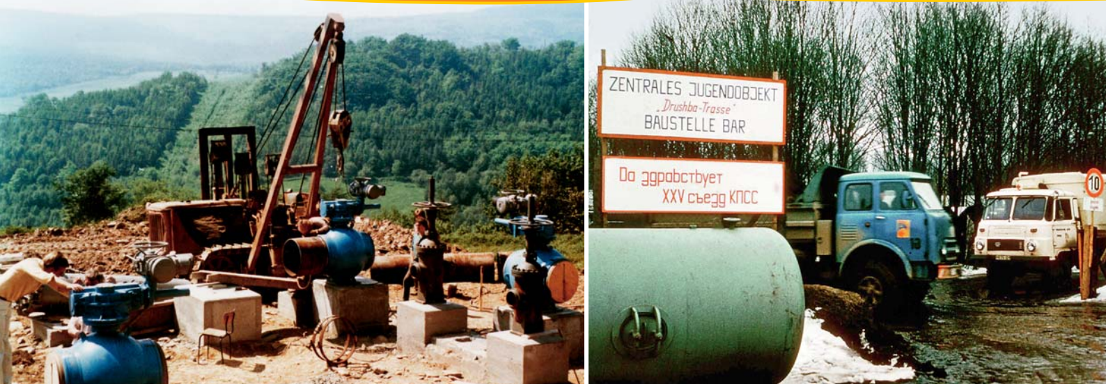
Bau einer Molchstation für die Importerdgasleitung (IEGL) in den Kammlagen des Erzgebirges bei Deutschneudorf Anfang der 1970er Jahre. Am Grenzübergangspunkt Sayda/Deutschneudorf im sächsischen Erzgebirge strömte am 1. Mai 1973 schließlich erstmals russisches Erdgas nach Deutschland. | Zentrales Jugendobjekt „Drushba-Trasse“.
