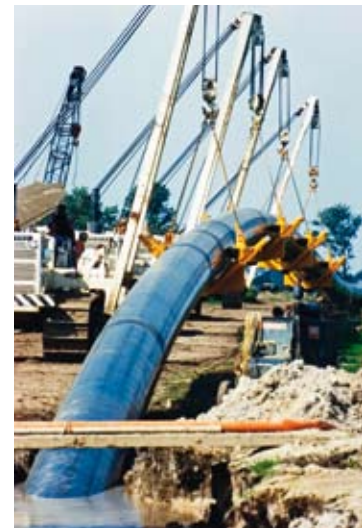
Neubau der Flußquerung der Havel im Rahmen der Erdgasumstellung und Netzsanierung.
