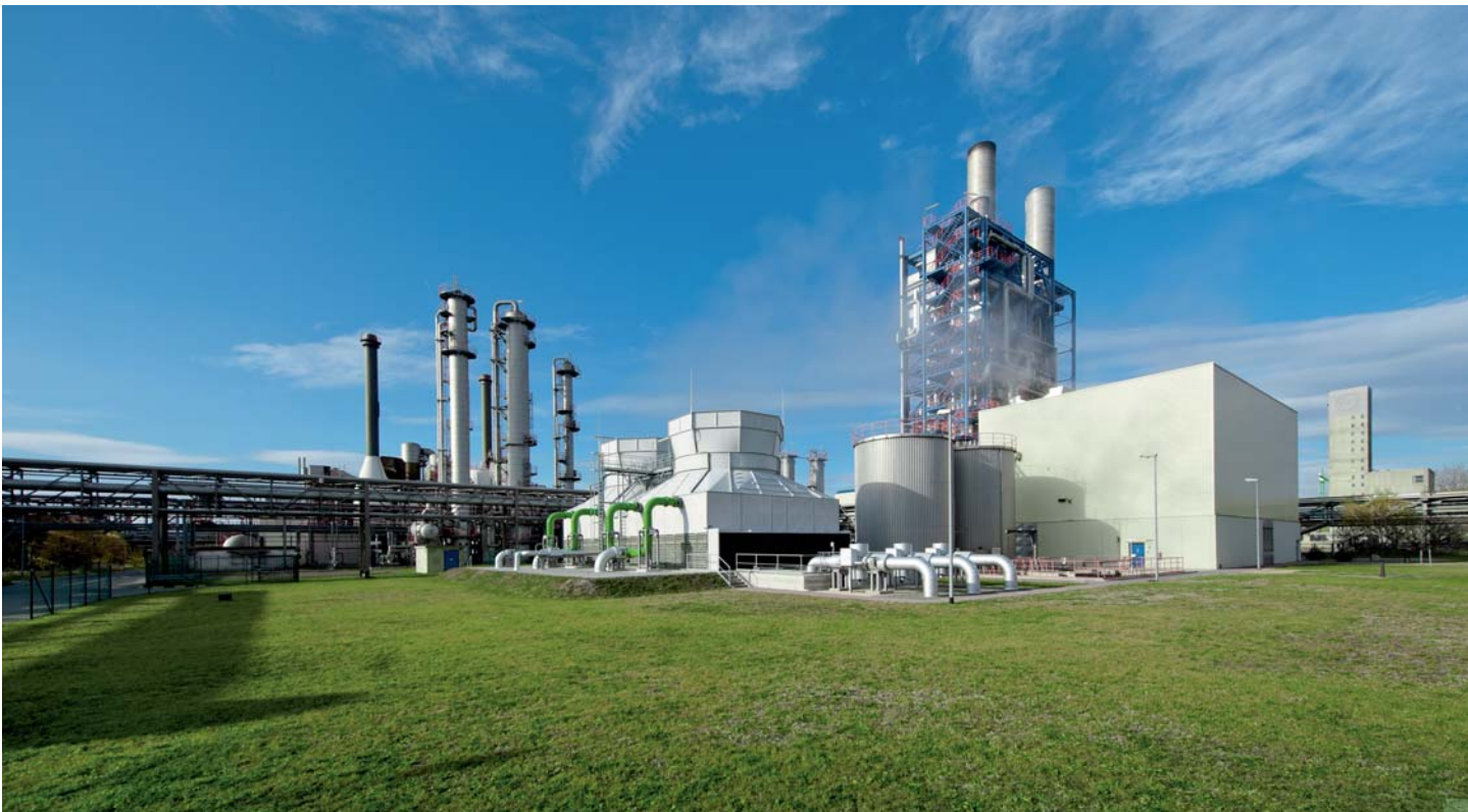
Stromproduktion mit Erdgas – ALPIQ-Kraftwerk in Spreetal mit dem 55-Meter-Dampferzeuger im Hintergrund und den beiden Kühltürmen im Vordergrund.
