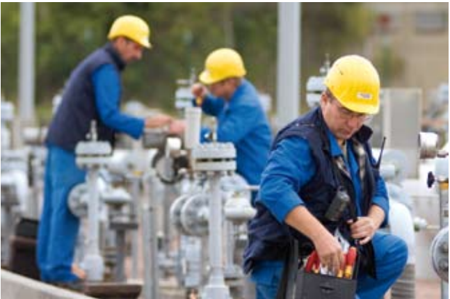
Wartung an den Regelschienen.
