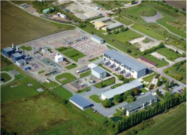
Obertageanlage des Untergrundgasspeichers.
