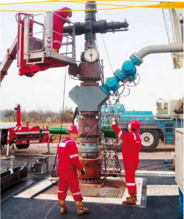
Arbeiten an einem Kavernenkopf.
