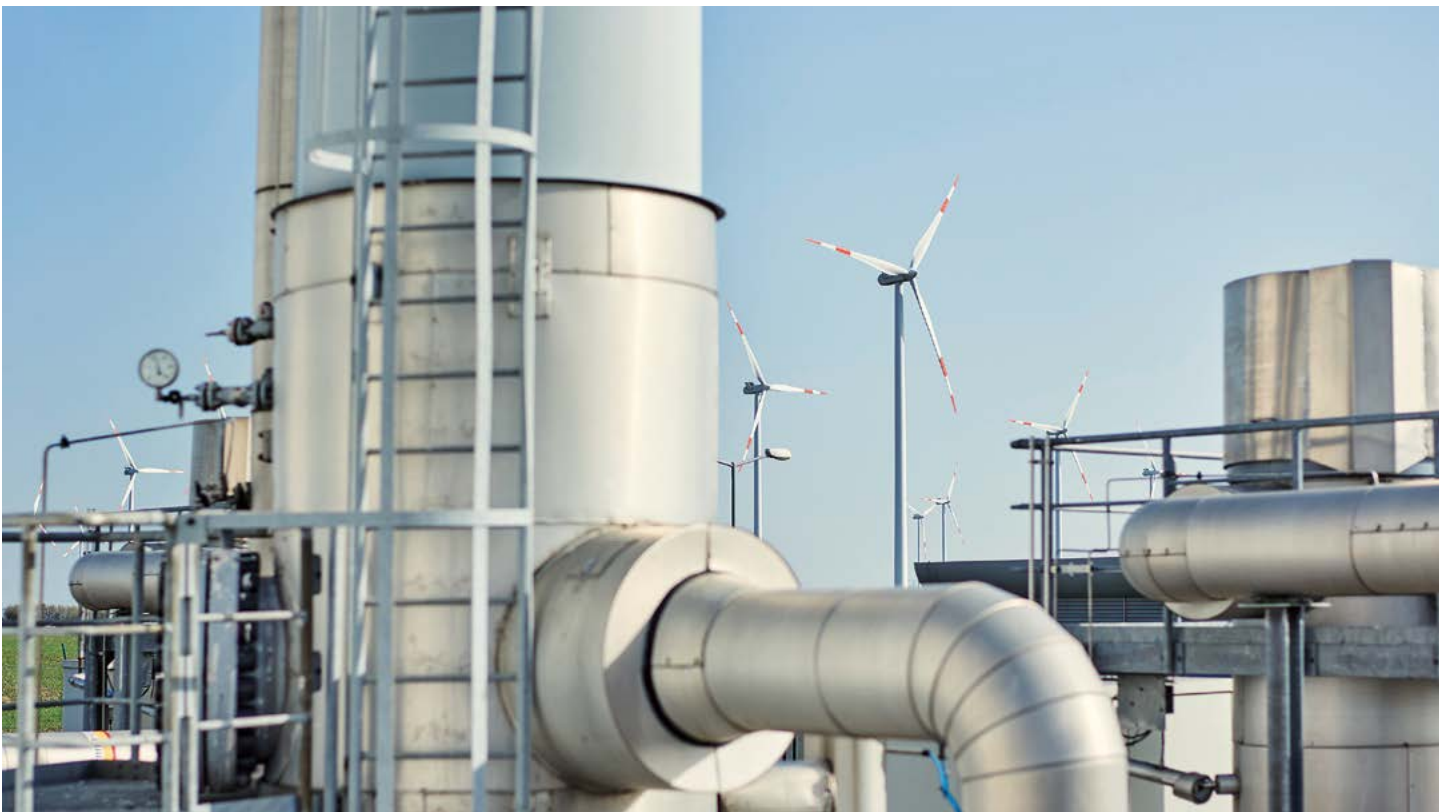
Herstellung, Transport und Speicherung von grünem Wasserstoff: Das Power-to-Gas-Konzept könnte ab 2021 im „Energiepark Bad Lauchstädt“ im industriellen Maßstab erprobt werden.
